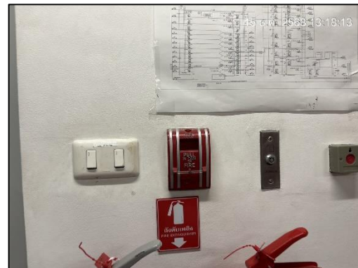
ภาพที่ 42 อุปกรณ์แจ้งเหตุด้วยมือ (Manual Pull Station)
