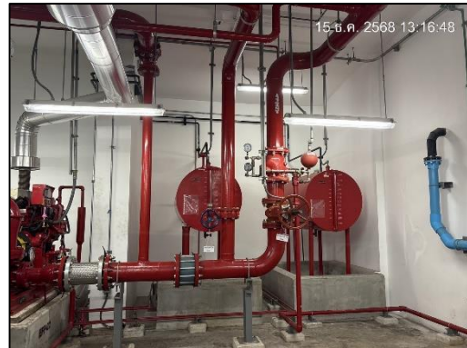
ภาพที่ 35 ระบบท่อขึ้น (Stand Pipe)
