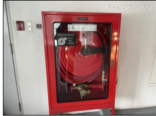
ภาพที่ 38 ตู้เก็บสายฉีดน้ำดับเพลิงพร้อมอุปกรณ์
