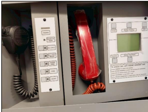
ภาพที่ 51 โทรศัพท์ฉุกเฉิน (Telephone Jack)
