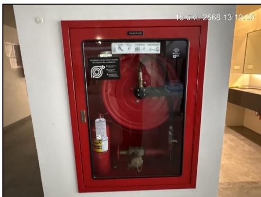
ภาพที่ 38 ตู้เก็บสายฉีดน้ำดับเพลิงพร้อมอุปกรณ์
