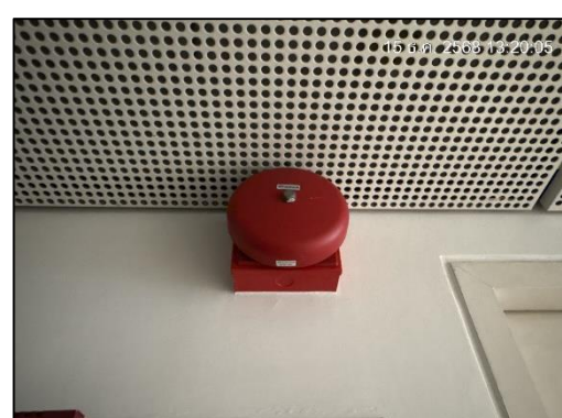
ภาพที่ 44 กระดิ่งสัญญาณแจ้งเหตุเพลิงไหม้ (Alarm Bell)
