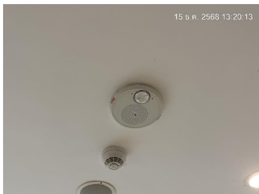
ภาพที่ 43 ลำโพงแจ้งเหตุเพลิงไหม้ (Alarm Speaker)
