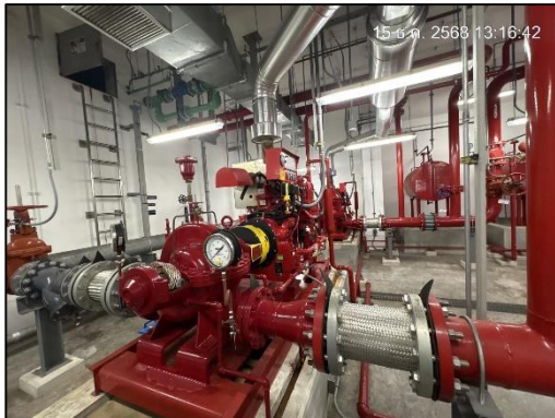
ภาพที่ 34 เครื่องสูบน้ำดับเพลิง (Fire Pump)
