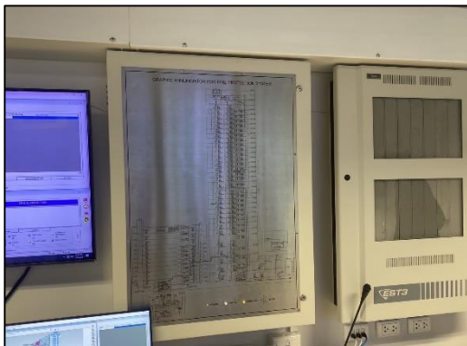
ภาพที่ 41 แผงควบคุม (Fire Alarm Control Panel : FCP)
